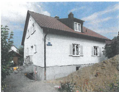
Das Haus hatte enorme Feuchteschäden. Für die Sanierungsmaßnahmen musste der Keller außen freigelegt werden.
