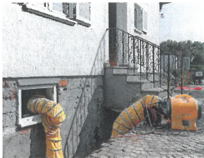
Professionelle Trocknung: Die Feuchtigkeit ist sowohl aus dem Erdreich als auch von der Seite eingedrungen.
